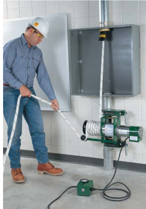
Verwendung von Spannketten bei Montage am Kanal
